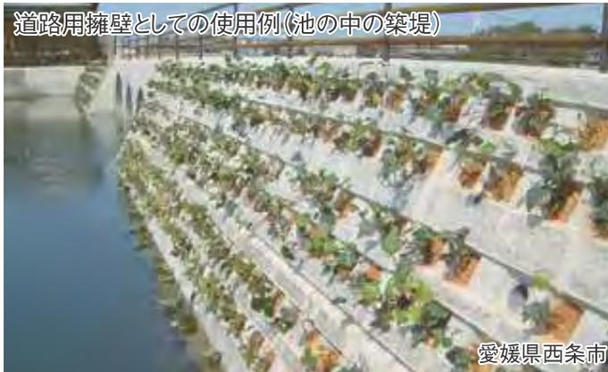
道路用擁壁としての使用例 (池の中の築堤)
