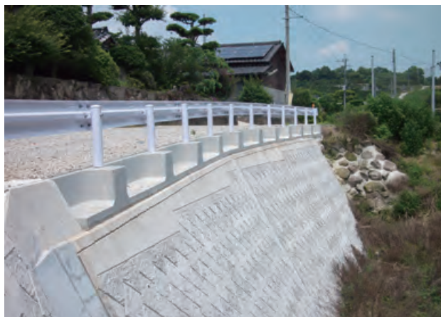
ブロック積み擁壁
