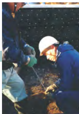
3 KCパネル固定ナットの取付け
