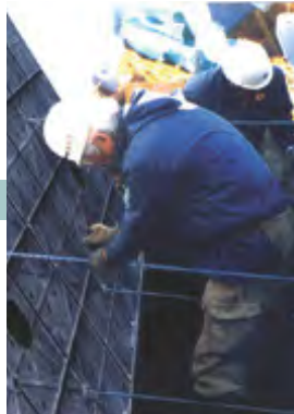
5 KCパネルの固定
