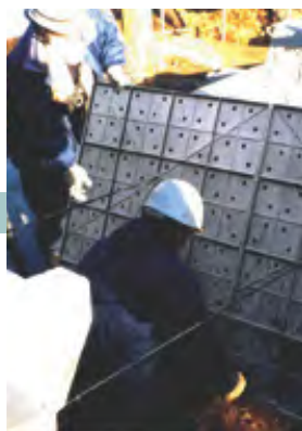
2 KCパネルの取付け
