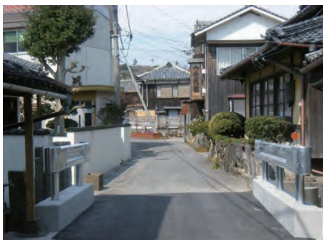
舗装・ガードレール設置完了
