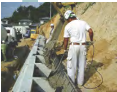
4 胴込コンクリートの打設
