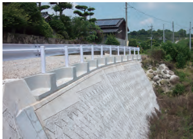
ブロック積み擁壁
