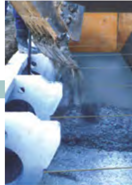
7 胴込・裏込コンクリートの打設
