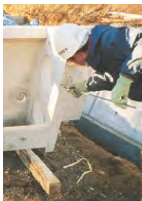
1 セパレーターの取付け
