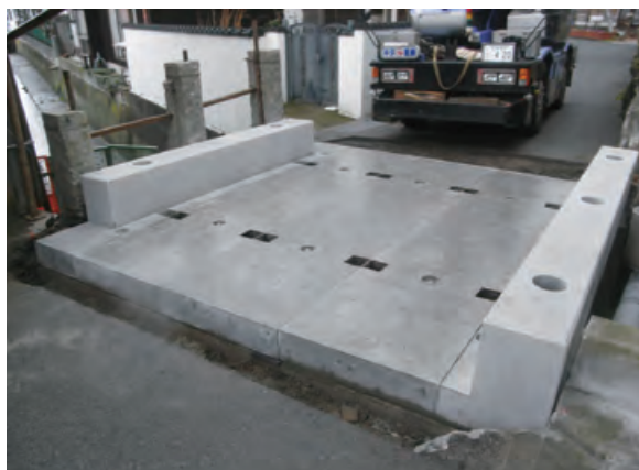
床版施工完了
