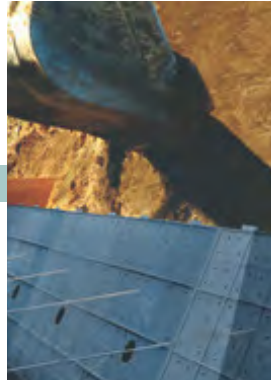
6 裏込材料の投入
