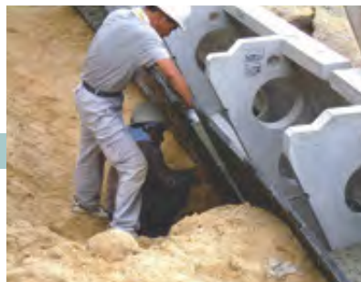
2 KCパネルの固定
