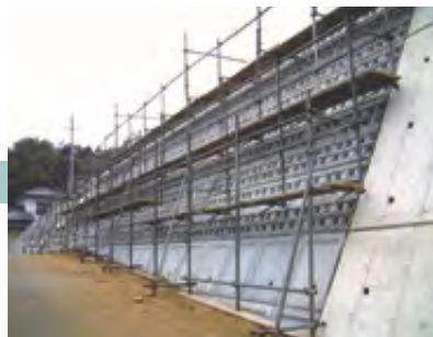
5 据付け完了及び足場設置
