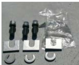
躯体ブロックを設置後、 の様にワッシャを入れ、 の様に半月板ワッシャを180°回転させ、ボルトを締め付ける。
